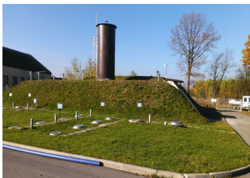
Stacja Uzdatniania Wody w Paruchach
