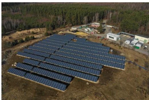
Instalacja fotowoltaiczna na składowisku w Końskich
