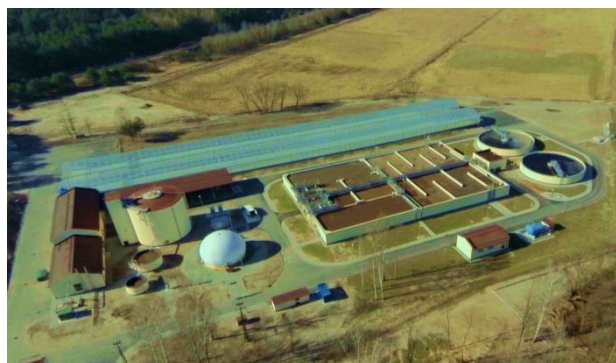
Oczyszczalnia ścieków w Kornicy
