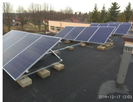
Instalacja na budynku ZSP w Nieświniu
