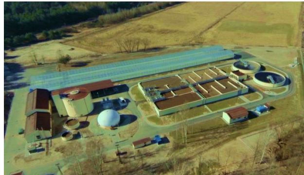
Oczyszczalnia ścieków w Kornicy
