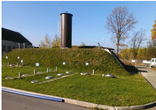
Stacja Uzdatniania Wody w Paruchach
