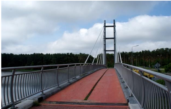
Most na Sielpi w ciągu drogi nr 728
