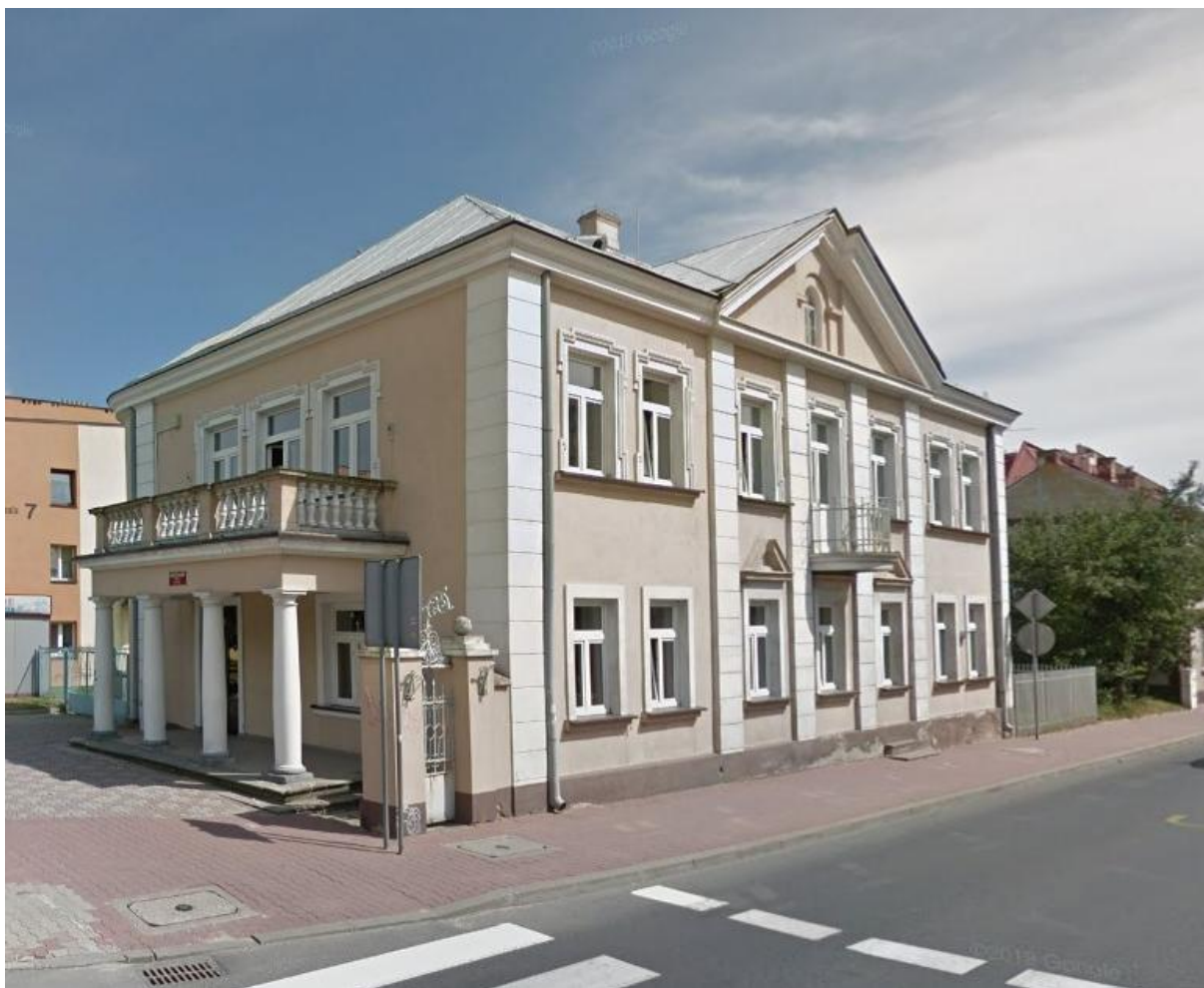
Ryc. 30 – Zabytkowy budynek - lokalizacja Centrum Wielopokoleniowego - przedsięwzięcia C11
